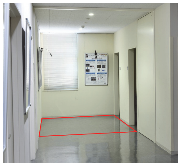
図5：工3号館1F「交流ラウンジ」候補地。防火扉の奥側（炊事スペースとゴミ箱がある）を総合的に再開発。
